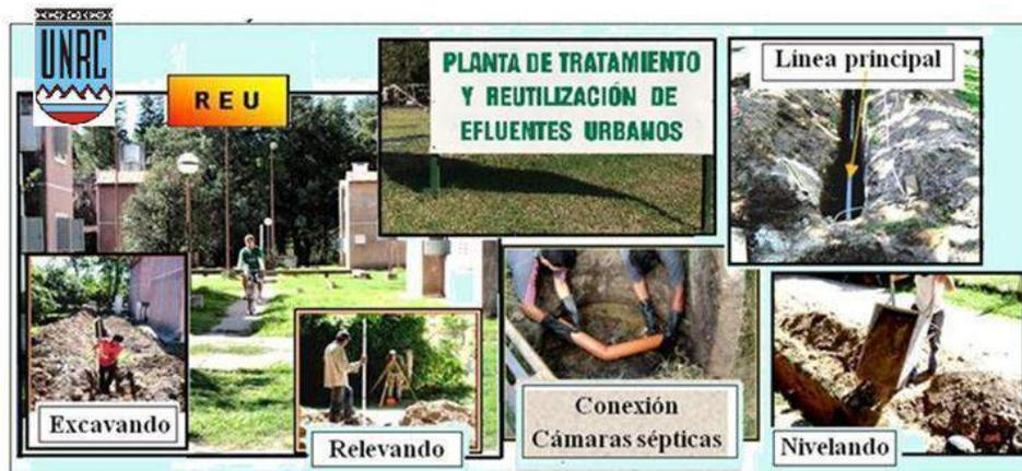
Figura 1. Trabajos previos de interconexión de la red cloacal. UNRC. Río Cuarto. Córdoba.
